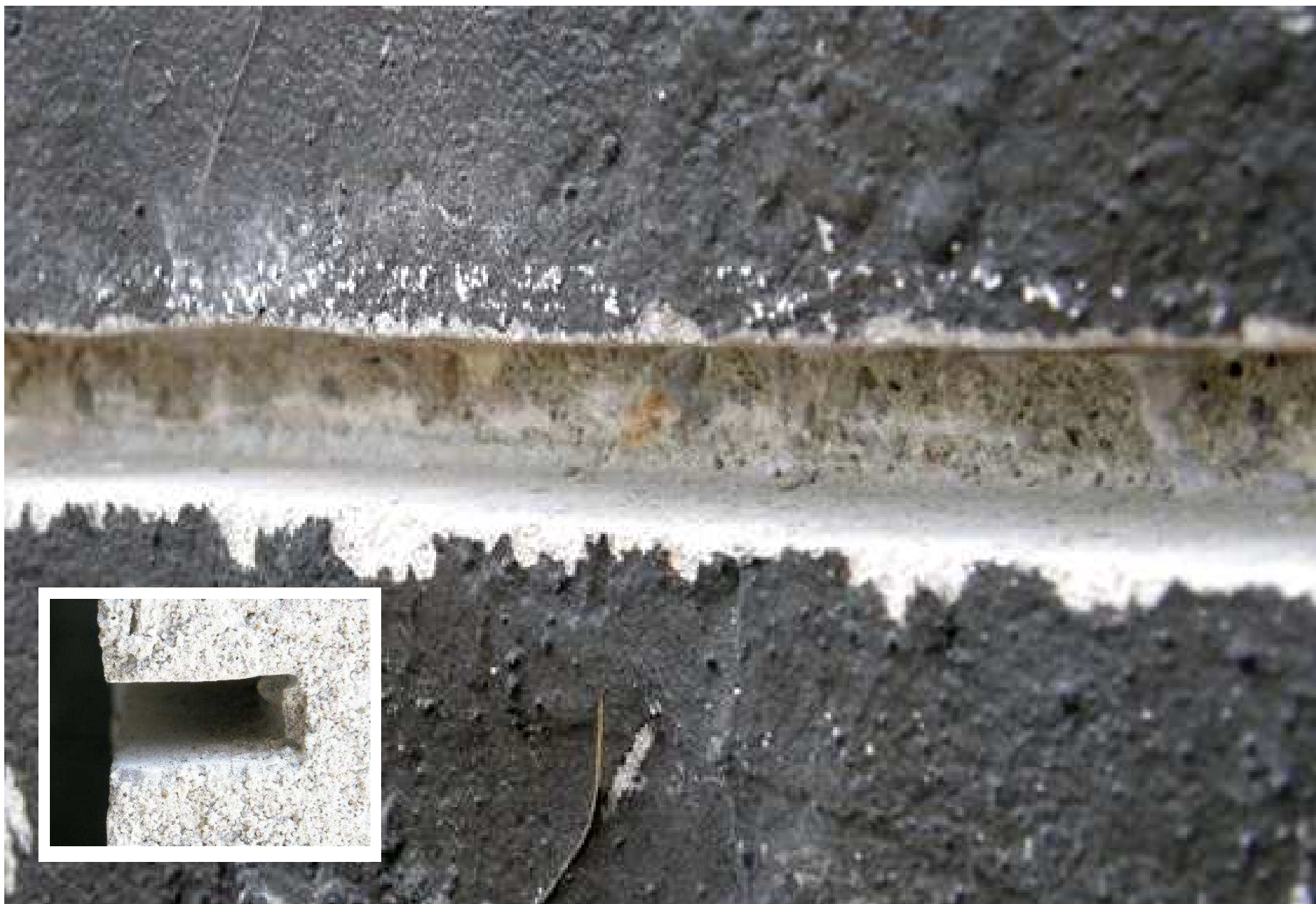
Wyfrezowana szczelina oczyszczona powietrzem i przygotowana do montażu Saver Profilu
