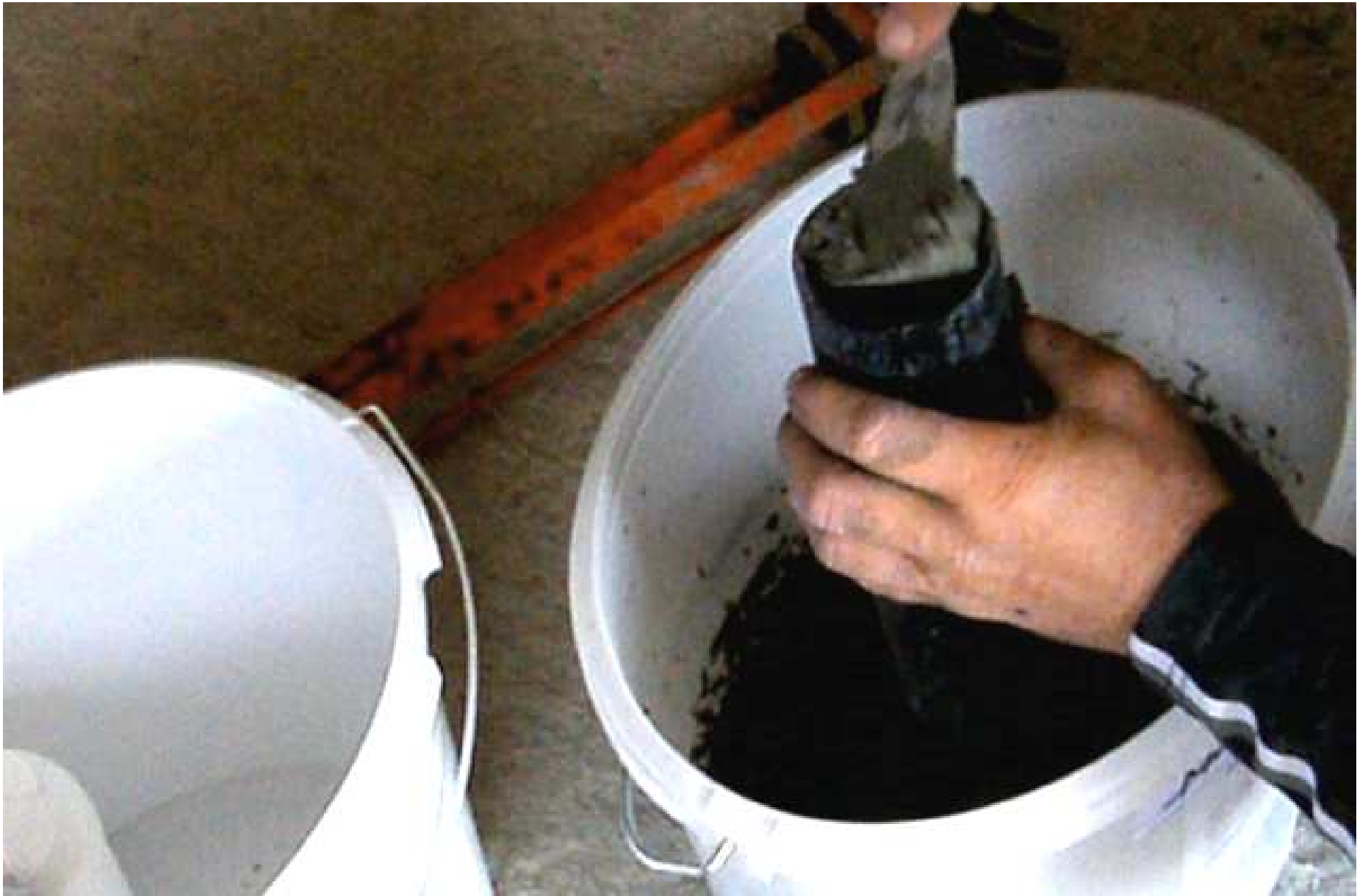
7. Używając szpachelki nappełnić zaprawą Saver Powder tubę pistoletu iniekcyjnego
