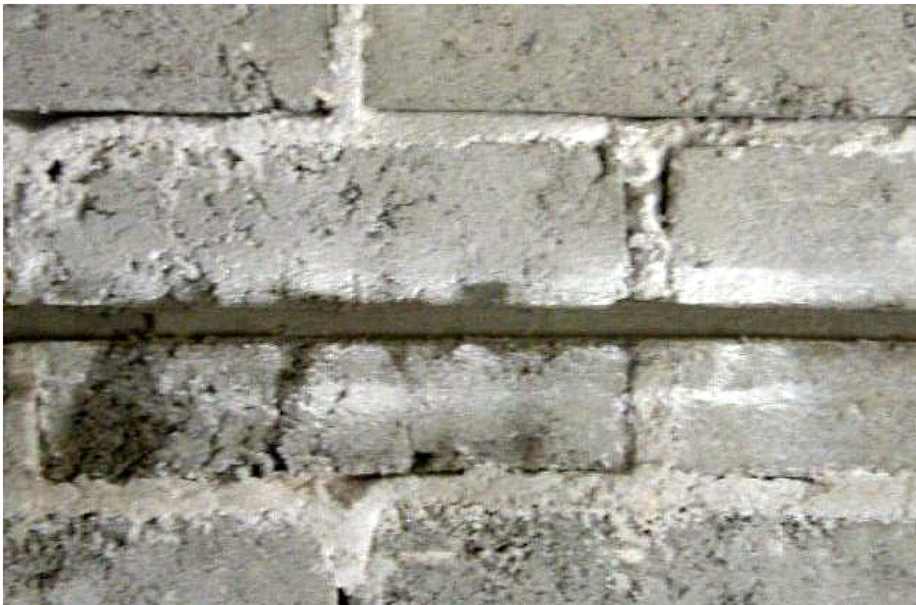
Zamontowany „na gotowo” Saver Profil w szczelinie
