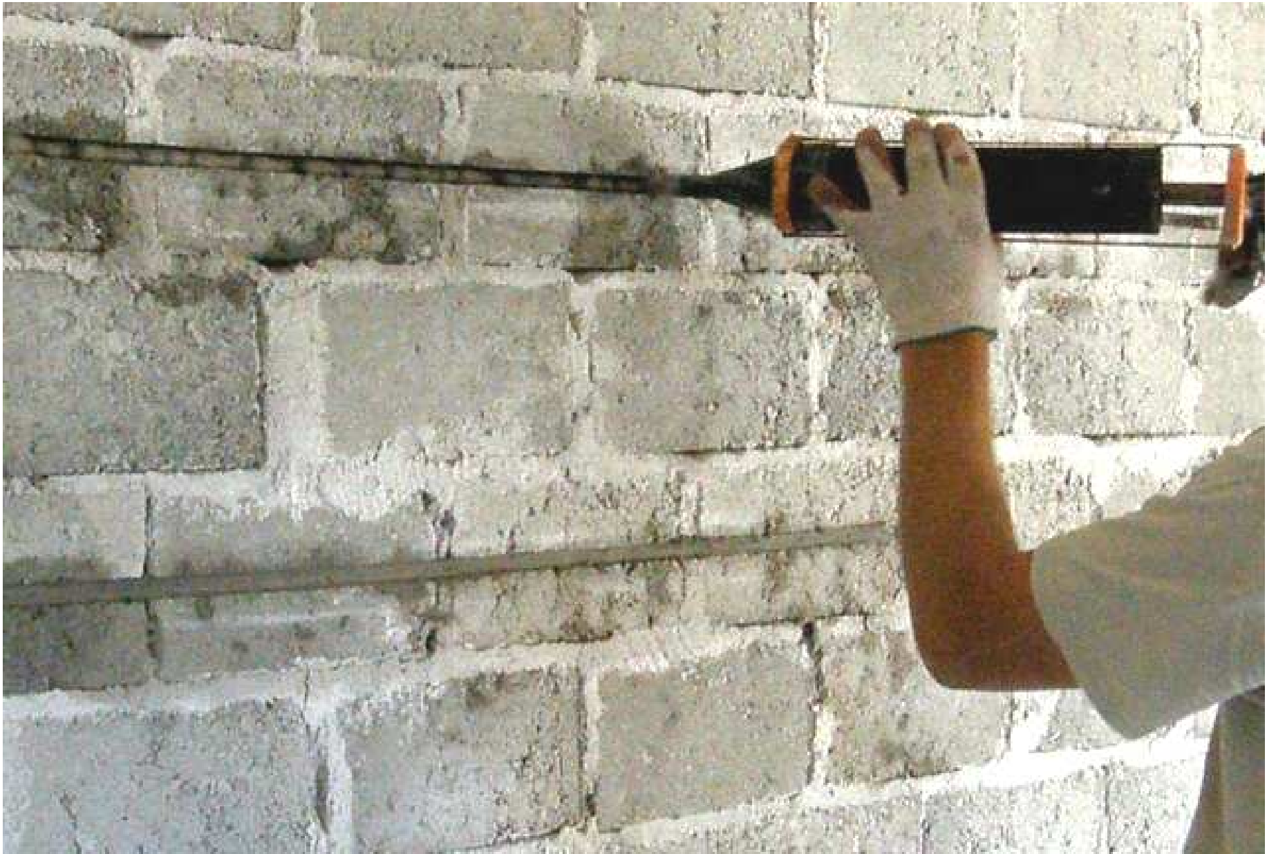
12. Wypełnić szczelinę drugą warstwą zaprawy Saver Powder - kolejny „wałek” o średnicy około 1 cm
